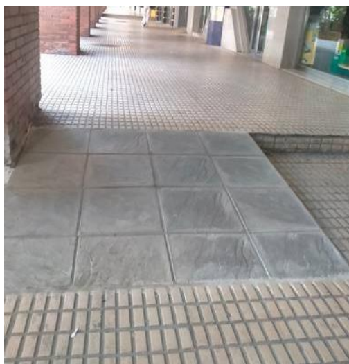
Imagen de la rampa recientemente instalada.
